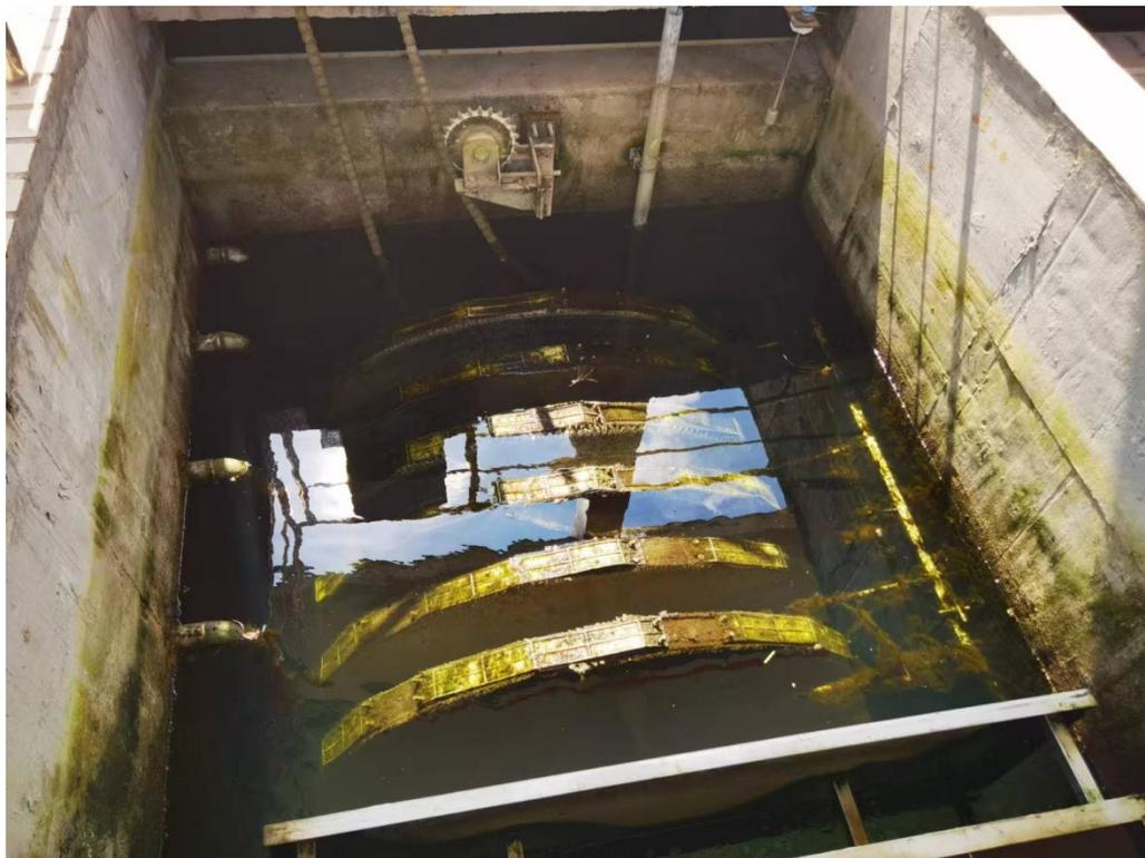
6、厂区：设备底座油漆脱落，防水效果欠佳；
