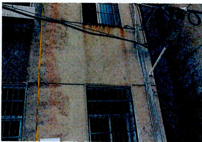
图 16 墙体外抹灰层基本牢固，稍有风化污损、未见明显损坏
