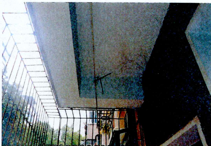
图 8 挑梁完整牢固，无下挠、变形
