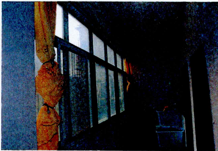
图 7 砌体自承重墙基本平直牢固，未见明显倾斜，变形
